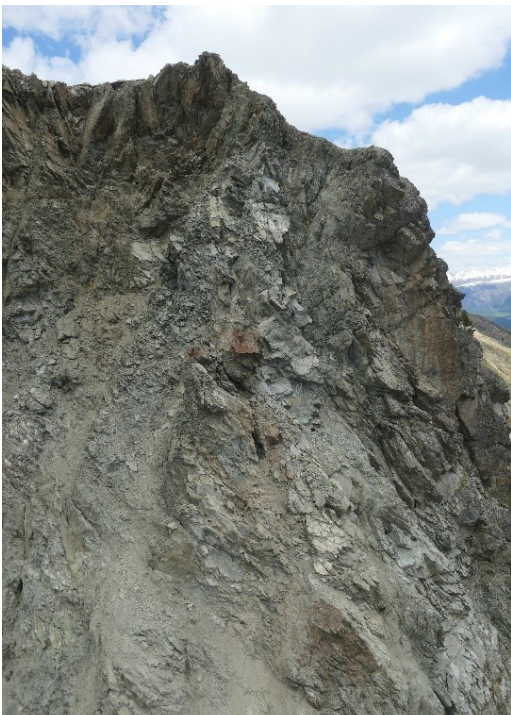
Immagine 2: La parete rocciosa della Blais Parè costituisce la zona di distacco. Lo gneiss è fortemente frammentato e altamente esposto all'erosione a causa di acqua, vento e processi di gelo-disgelo. Nel complesso la massa rocciosa è però stabile e non si registrano movimenti.
