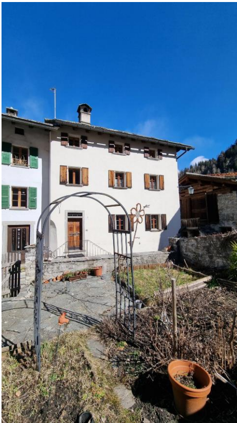
Facciata sud con giardino
