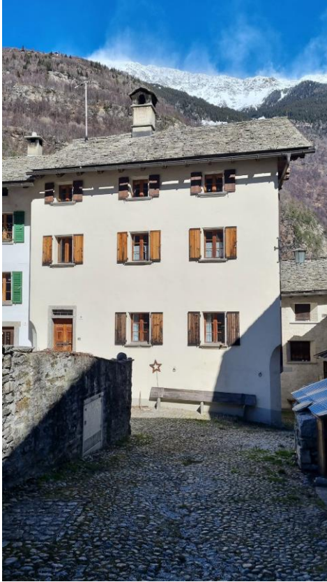
Entrata, facciata sud
