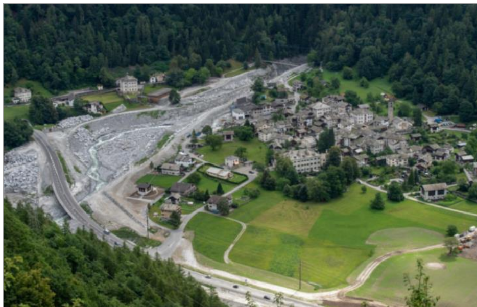
Immagine 2: Situazione collegamenti stradale e impianti di protezione estate 2018
