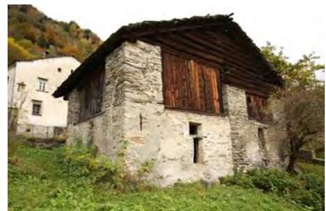
Stalla fienile – Edificio doppio. La copertura necessita di lavori di manutenzione.
