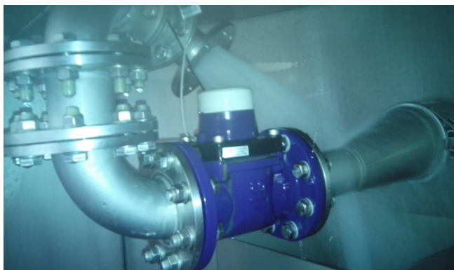
Figura 4-4: Misuratore del deflusso della Vasca raccolta Bürdagh – Meistream mit GWFcoder® DN80, Q3 120, PN 16, L=225 mm
