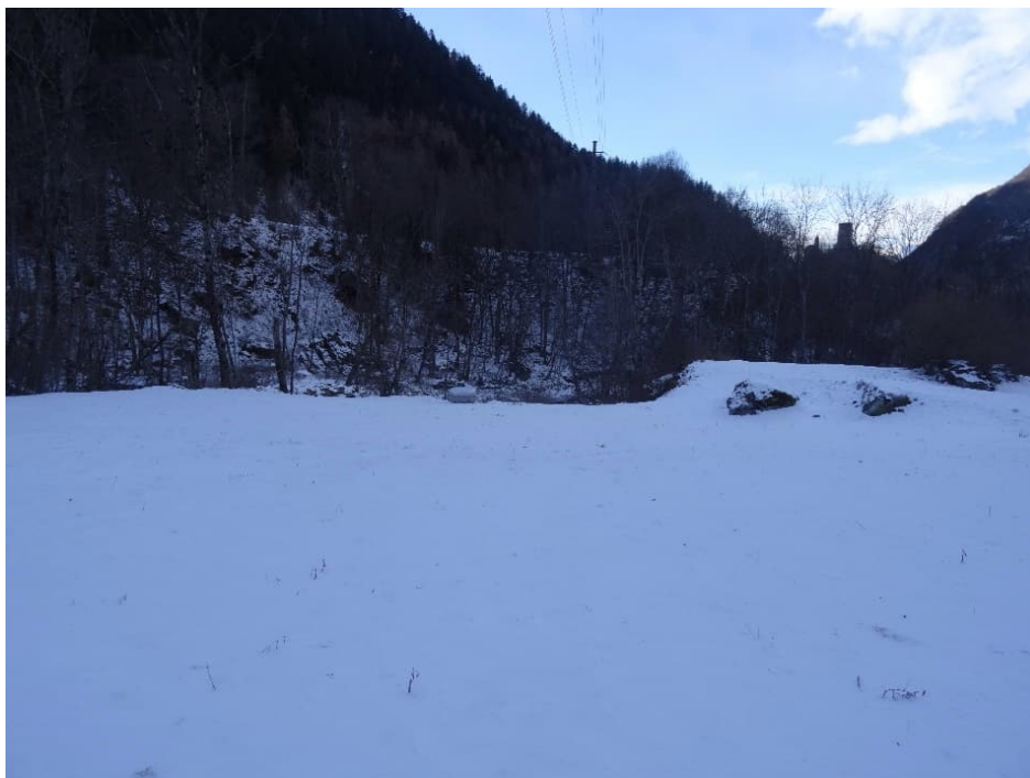
Figura 10-14: Zona centrale idroelettrica (21.1.2023)
