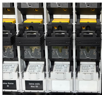
Figura 4-17: distribuzione 420V Trasformatore Montaccio-Caccior
