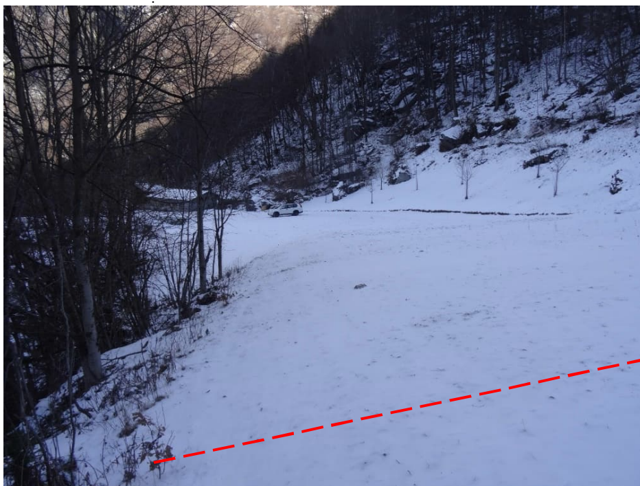
Figura 10-10 Zona Palza – Canale di scarico (condotta DN300 in trincea) (21.1.2023)
