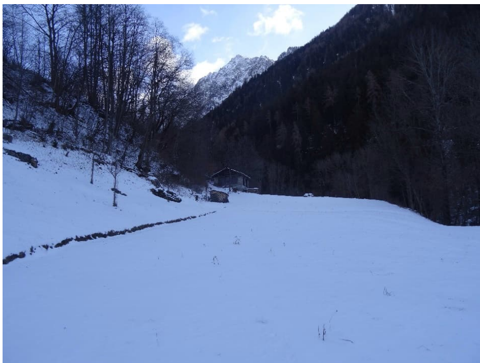
Figura 10-12: Zona centrale idroelettrica (21.1.2023)
