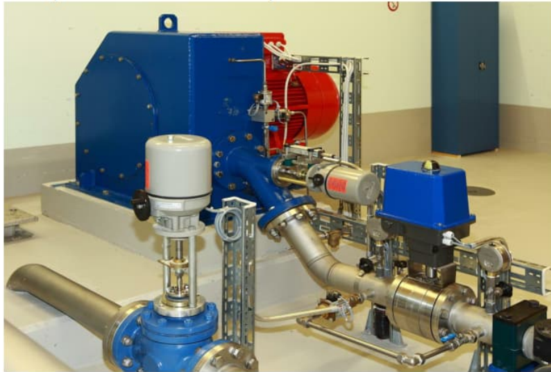
Figura 4-14: Turbina Pelton ad asse orizzontale con 1 getto (fonte: Referenze Andritz Hydro AG)
